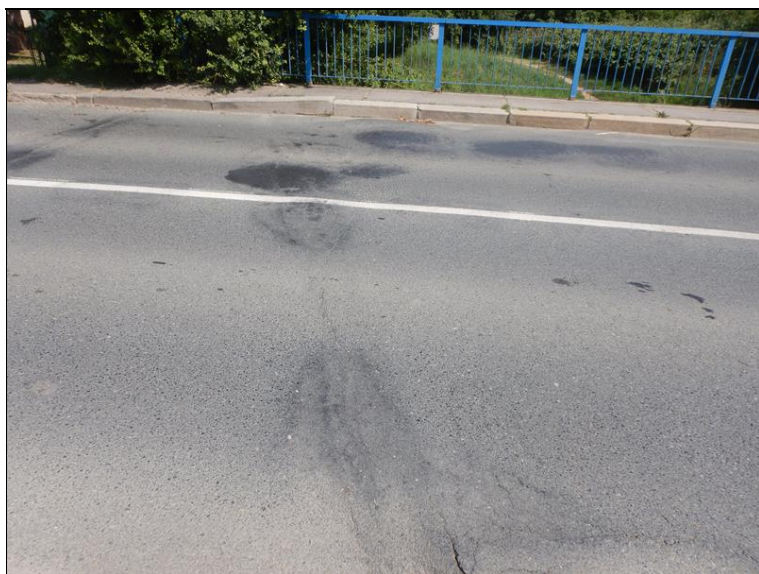
12.JPG Kryt vozovky v místě podpovrchové dilatace nad Op1.
