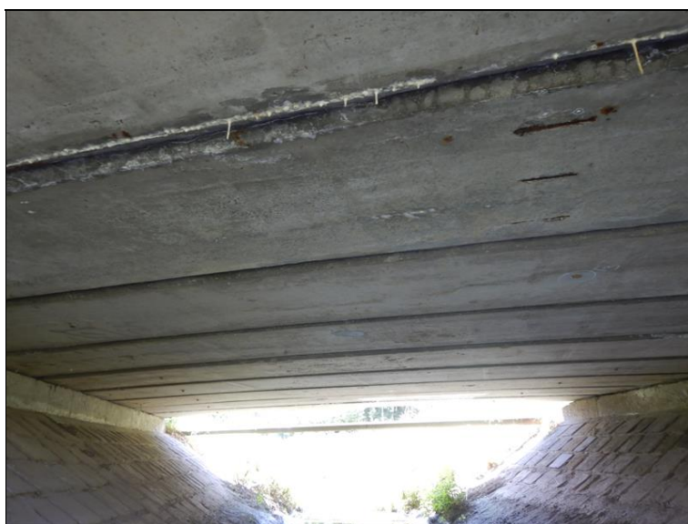
9.JPG Podhled nosné konstrukce (NK) ve směru pohledu k pravé straně mostu. Patrné průsaky spárou mezi krajními nosníky zleva. Na podhledu 2. nosníku zleva stopy průsaků dnem nosníku a lokálně obnažená výztuž.
